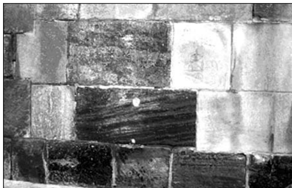
Obr. 11. Materiálová heterogenita stavebního kamene Karlova mostu
