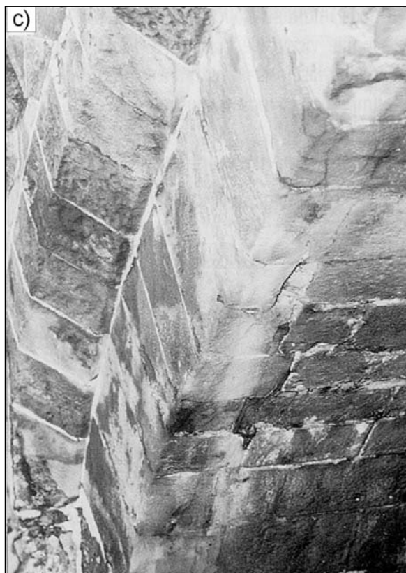
Obr. 19. Tahové trhliny, prosakování srážkové vody a usazené soli na lícní ploše mostních kleneb (a, b); narušení klenbového zdiva v místě uložení poprsní zdi (c); trhliny v poprsní zdi (d)
