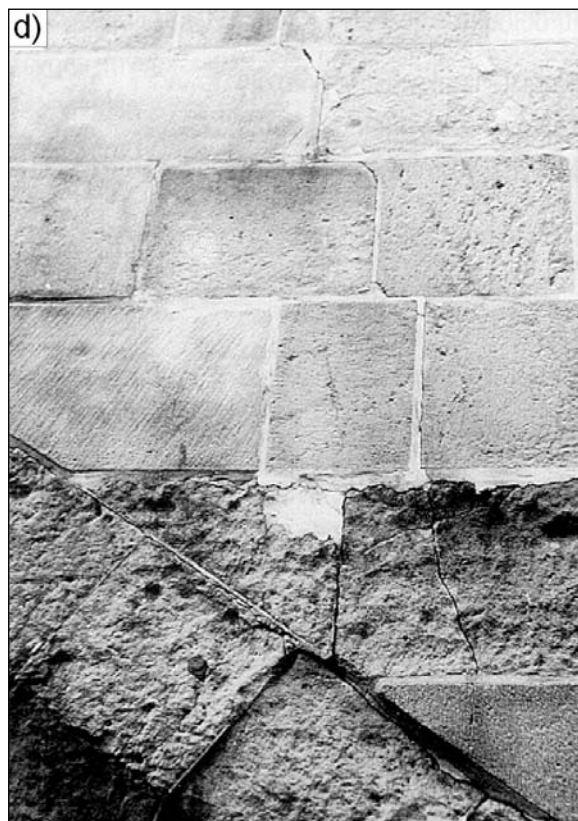
Obr. 19. Tahové trhliny, prosakování srážkové vody a usazené soli na lícní ploše mostních kleneb (a, b); narušení klenbového zdiva v místě uložení poprsní zdi (c); trhliny v poprsní zdi (d)
