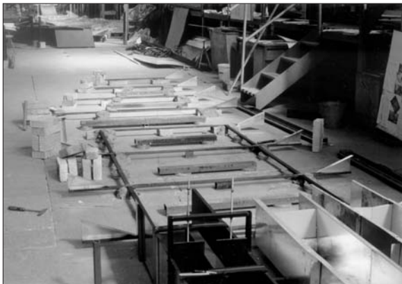
Obr. 5. Osazování příčných profilů na podlahu haly
