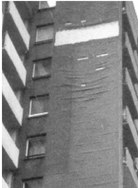
Obr. 3. Porušení kontaktního zateplovacího systému difúzí vodních par (boulení, vznik trhlin a narušování tenkovrstvé omítky v místě spáry mezi deskami polystyrenu)
