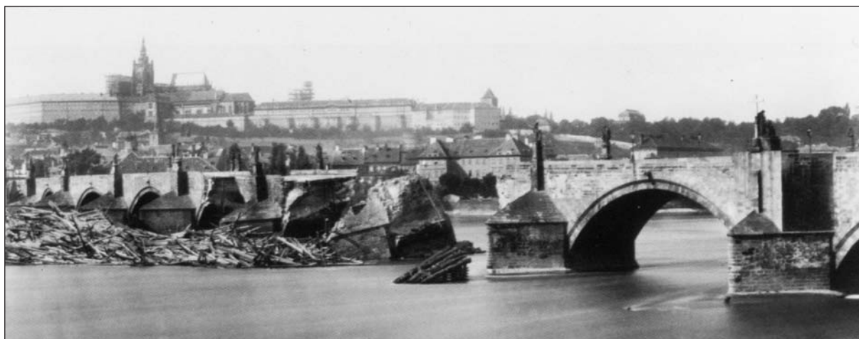
Obr. 1. Zřícení polí Karlova mostu 4. 9. 1890 [4]
