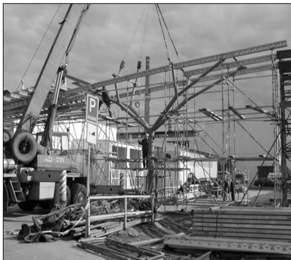
Obr. 7. Montáž bednění desky
