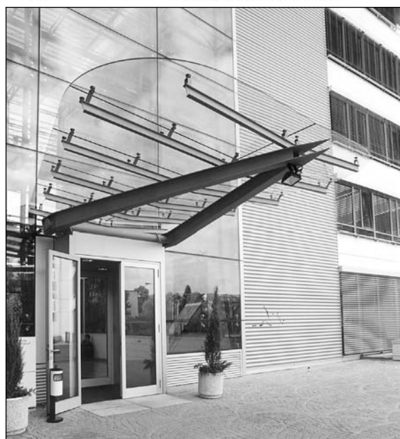
Obr. 7. Hadovka – skleněný přístřešek u zadního vchodu
