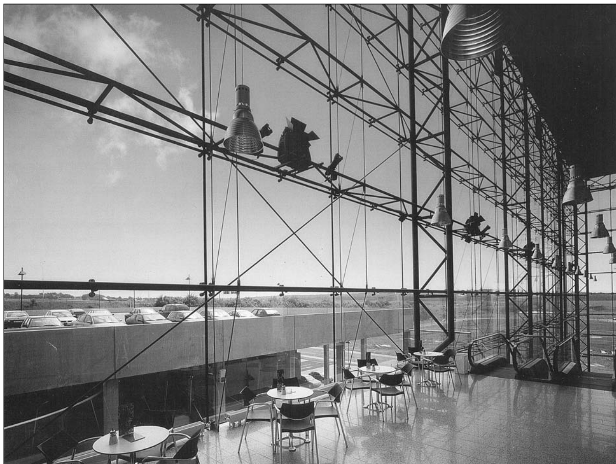
Obr. 14. Černý Most – průhled skleněnou stěnou
