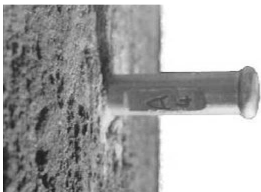
Obr. 2. Šroubovací nivelační značka s označením na pozorovaném bodě
