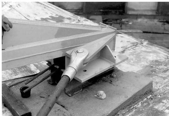
Obr. 3. Detail čepového spojení
