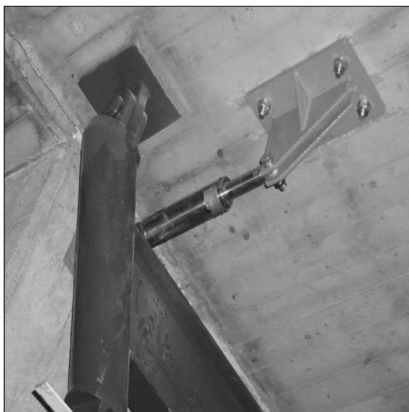
Obr. 6. Tlumič podélného kmitání
