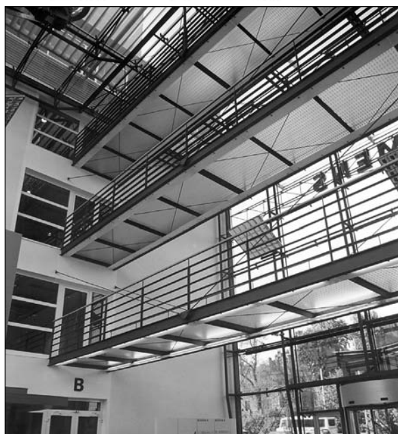
Obr. 6. Hadovka – interiér vstupu s lávkami zavěšenými na táhlech
