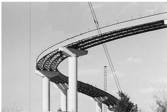
Obr. 1. Pocahontas Crossing, Richmond, USA montáž ocelové konstrukce
