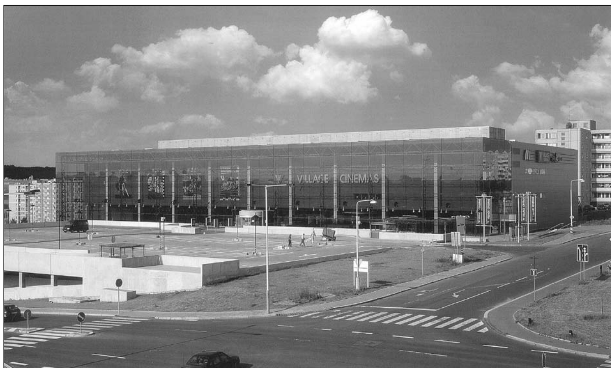
Obr. 13. Černý Most – pohled z dálnice
