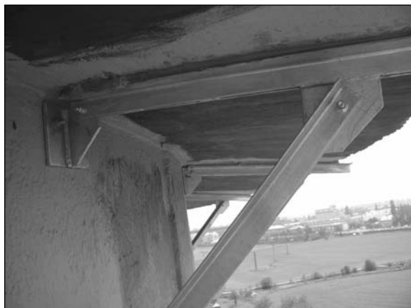
Obr. 2. Podchycení železobetonového ochozu ocelovými konzolami
