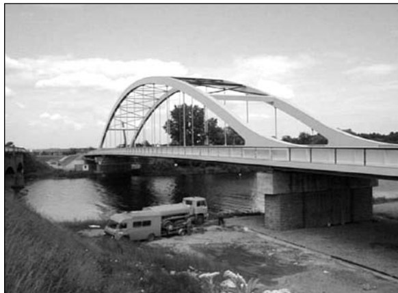
Obr. 8. Most přes Labe u Lysé nad Labem
