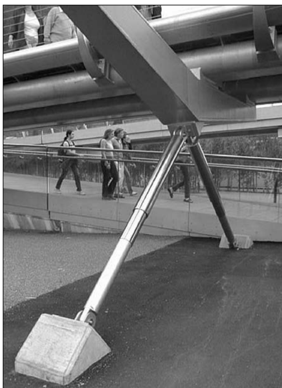
Obr. 2. Dodatečné tlumění svislého kmitání v krajním poli lávky Millennium
