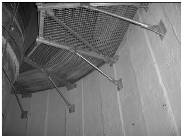
Obr. 4. Konstrukce nového ocelového vnitřního ochozu komína
