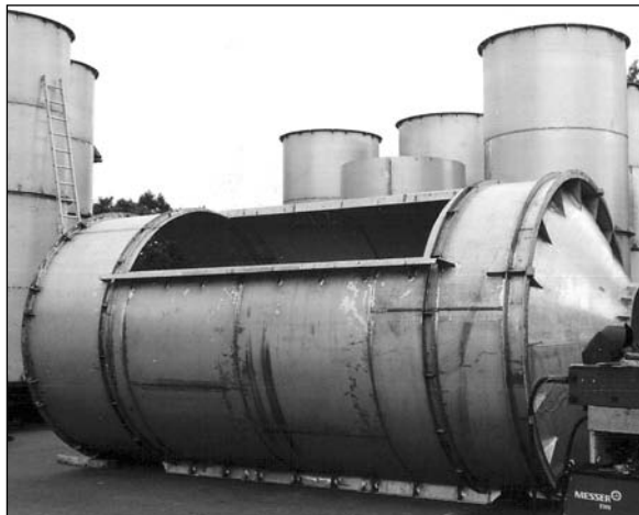
Obr. 3. Segmenty nového ocelového pouzdra před vložením do komína
