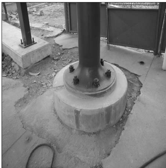
Obr. 4. Uložení podpory na základ
