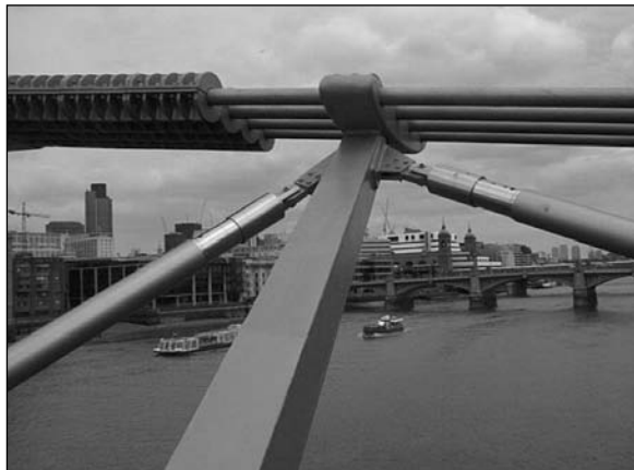
Obr. 1. Dodatečné tlumiče u lávky Millennium v Londýně
