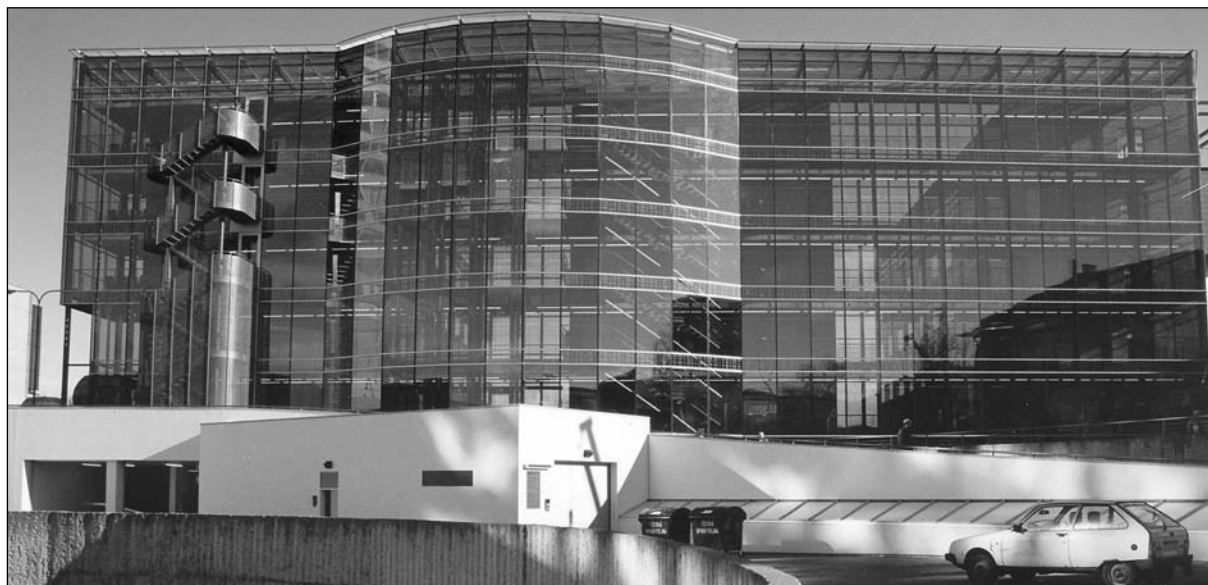
Obr. 1. Česká spořitelna v Praze 4 – celkový pohled
