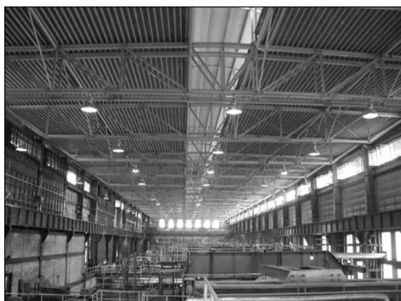
Obr. 9. Pohled do rekonstruované kotelny z kotle č. 4
