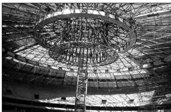
Obr. 17. Konstrukce střechy po odstranění provizorní podpory
