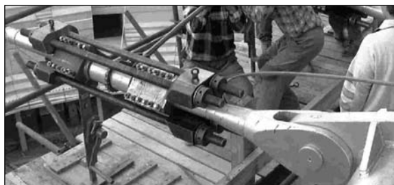
Obr. 16. Napínací zařízení u koncovky táhla
