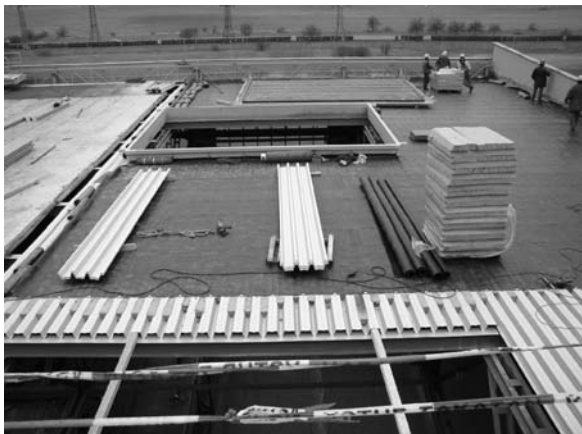
Obr. 3. Vyměňovaný střešní plášť v polích 32–34 s nezakrytým montážním prostupem
