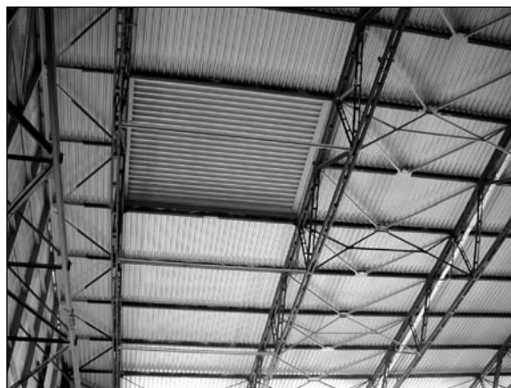
Obr. 5. Pohled na ztužidlové pole a trvalý montážní prostup s novým střešním pláštěm u jižní štítové stěny
