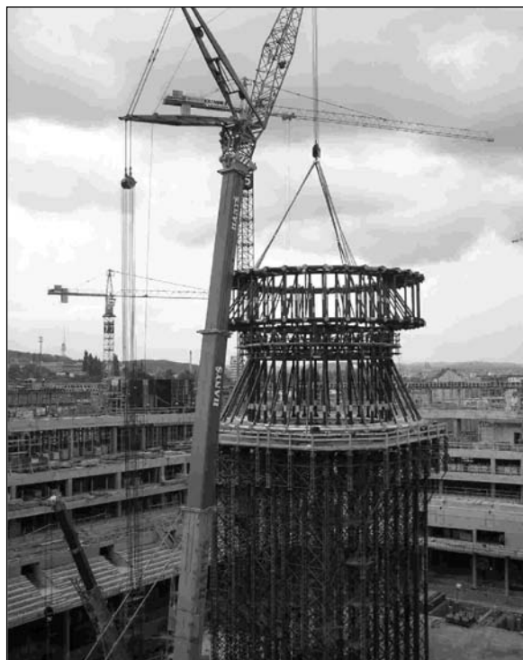
Obr. 8. Montáž tubusu na podpoře
