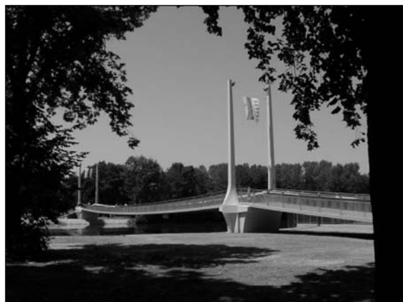
Obr. 3. Lávka pro chodce přes Vltavu v Českých Budějovicích
