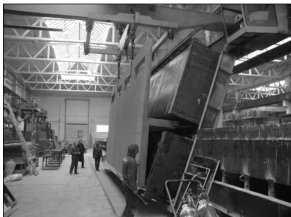
Obr. 2. Výroba dílců z lehkého betonu
