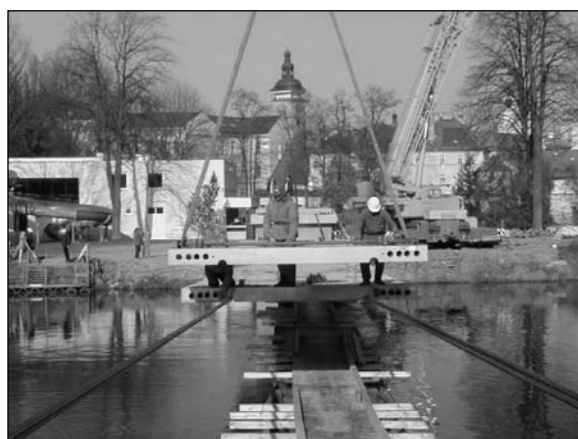
Obr. 5. Montáž dílců z lehkého betonu
