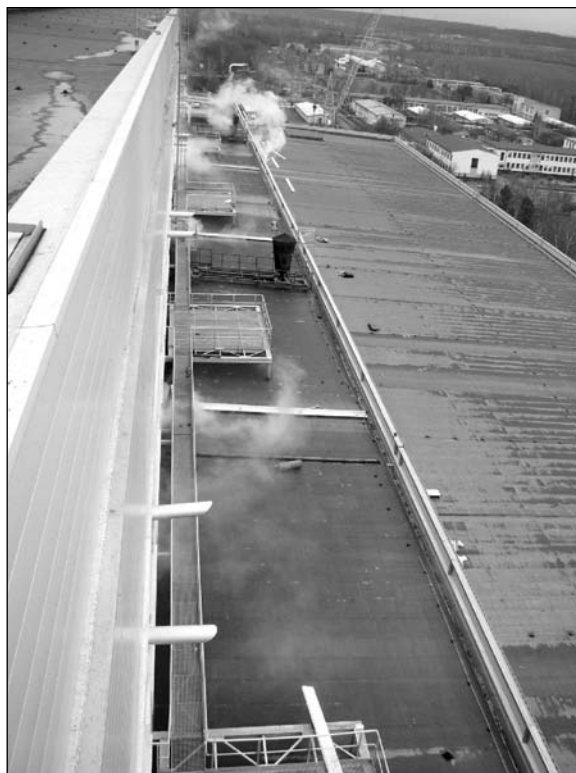
Obr. 7. Pohled na zrekonstruované střechy strojovny a mezistrojovny z kotelny
