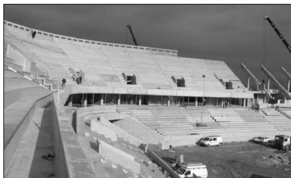
Obr. 1. Prefabrikovaná konstrukce tribun ve Wolfsburgu
