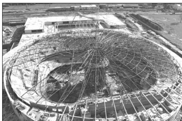
Obr. 1. Montáž konstrukce střechy s dočasnou střední podporou
