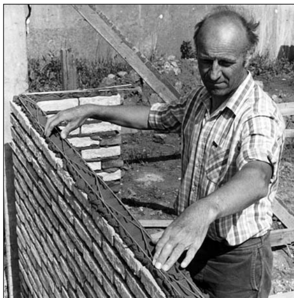
Obr. 1. Vkládání výztuže do ložných spár zdiva při zdění [6]
