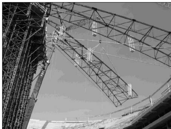
Obr. 10. Montáž dvojic vazníků s podvěšenými táhly
