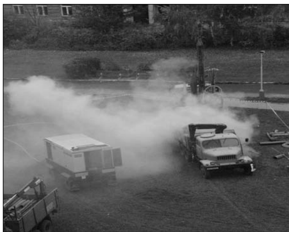
Obr. 1. Dokončování vrtu v podložní břidlici v areálu Fakulty stavební ČVUT v Praze
