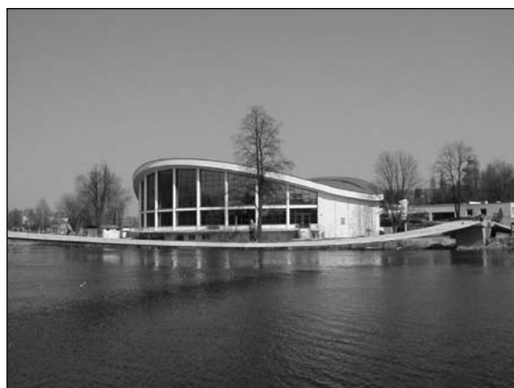
Obr. 4. Smontovaný předpjatý pás z lehkého betonu
