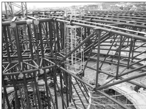
Obr. 5. Styk vazník-tubus
