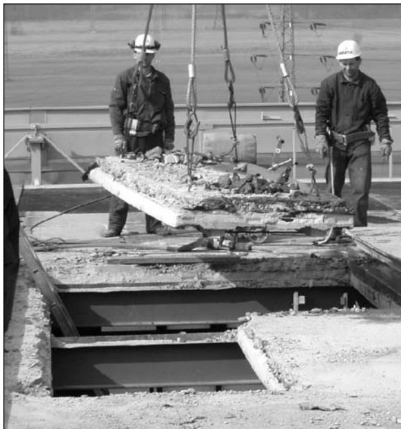
Obr. 4. Demontovaný žebříkový panel s vrstvou betonu
