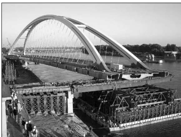
Obr. 11. Soulodí po odpojení od břehu
