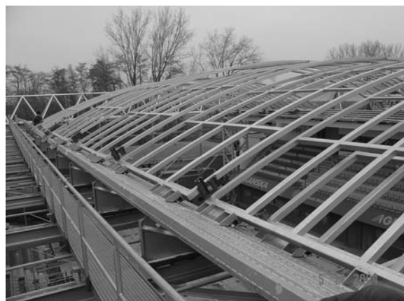
Obr. 8. Montáž segmentů zastřešení centrálního dvorce
