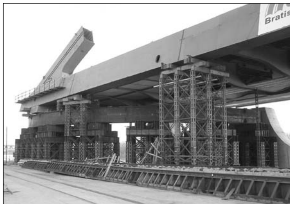
Obr. 3. Čtvrtkruhová dráha u pilíře č. 11
