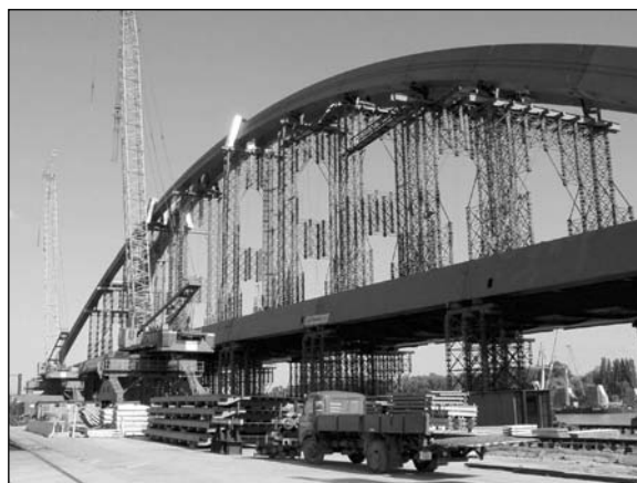
Obr. 2. Montážní podpěry mostovky a oblouku
