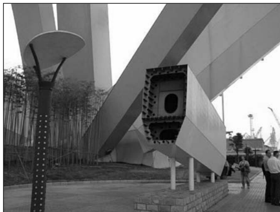
Obr. 6. Uložení oblouku a model průřezu
