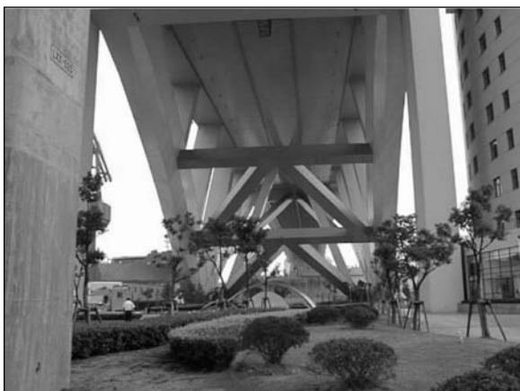
Obr. 5. Ztúžení pod mostem
