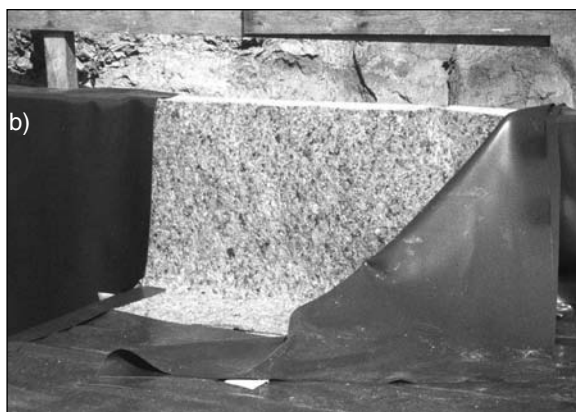
Obr. 2. Pokládání perlitových matrací v základové vaně pod nemocnicí v Praze 9 [5]
