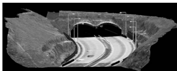
Obr. 13. Sesuv skalních stěn
