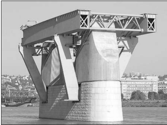
Obr. 6. Definitivní pilíř č. 10 osazený konzolami a montážním mostem
