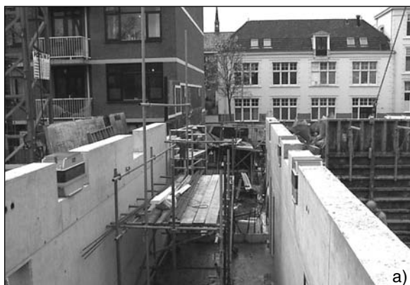
Obr. 3. Osazení ocelových pružinových prvků Gerb na základovou zeď v prostoru garáží nad stropem nádraží v Hamburku [2] a – pohled na osazování pružinových prvků, b – pohled zevnitř na zeď rozdělenou pružnými prvky
