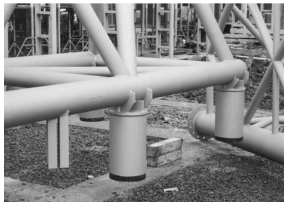
Obr. 3. Uložení vazníku na pylon před přivařením příruby
