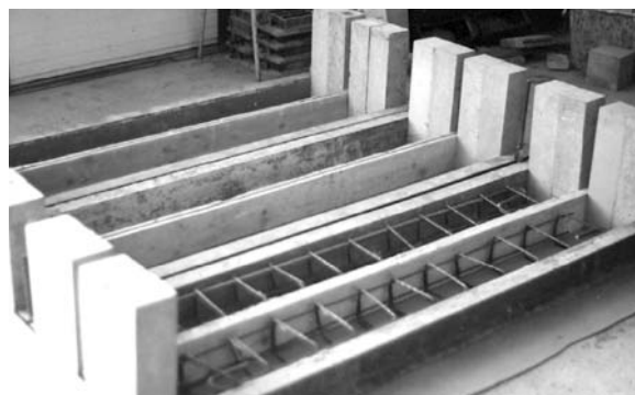
Obr. 1. Vystuženie nosníkov
