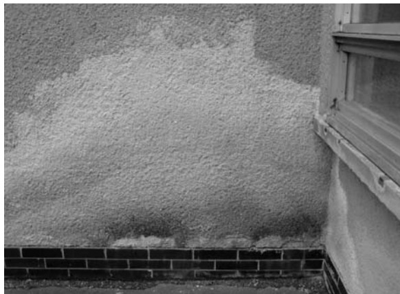
Obr. 1. Typický příklad šíření vlhkosti
