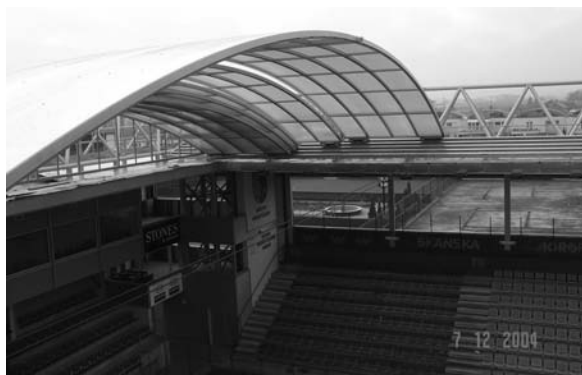
Obr. 6. Pohled na segmenty zastřešení centrálního dvorce
