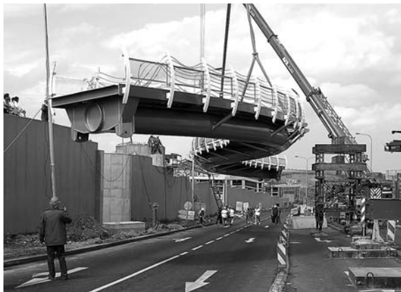
Obr. 9. Pohled na lávku při montáži
