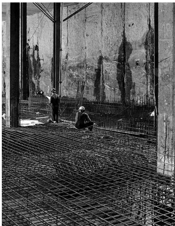
Obr. 6. Práce na úrovni základové desky
