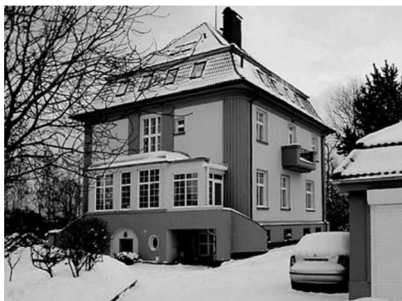
Rodinná vila Varnsdorf (prováděcí firma: Ladislav Žitek, Varnsdorf)
