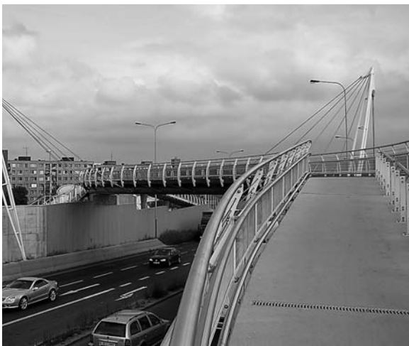
Obr. 13. Pohled na dokončenou lávku
