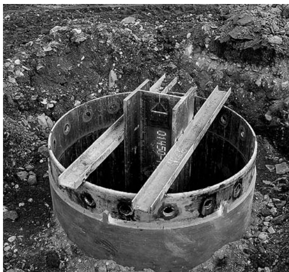
Obr. 4. Sloup profilu HD uchycený k hlavě výpažnice
