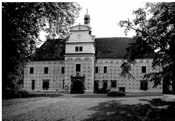
Renesanční sgrafitové fasády Zámku Doudleby nad Orlicí (prováděcí firma: Ing. Václav Hynek, Opočno)
