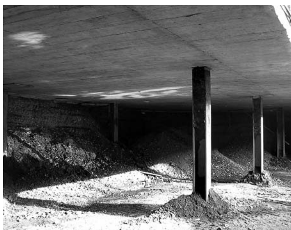
Obr. 5. Těžba pod prvním rozpěrným stropem
