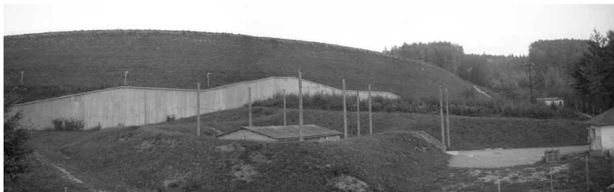
Obr. 1. Pohled na hráz z příjezdové cesty
