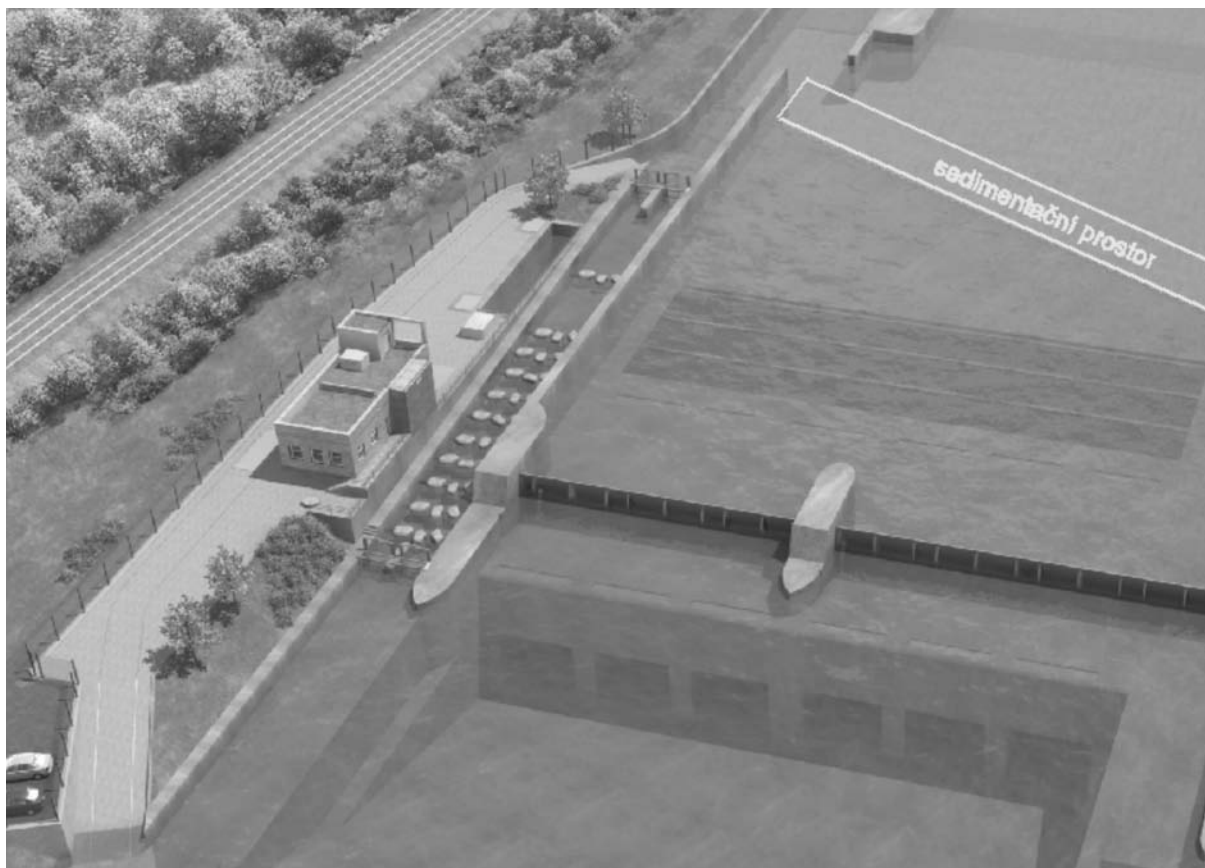
Obr. 1. Perspektiva elektrárny s vyznačením sedimentačního prostoru
