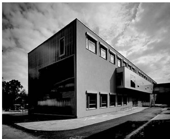
Areál Veterinární a farmaceutické univerzity Pavilon Hygieny, Brno
