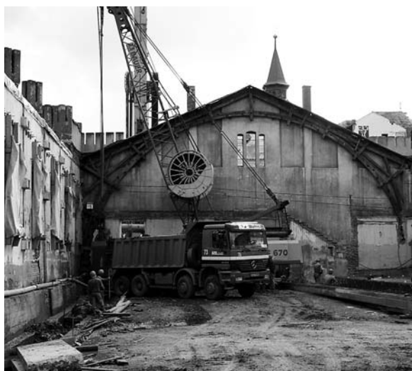
Obr. 3. Práce drapáku ve stísněném prostoru uvnitř budovy jízďárny
