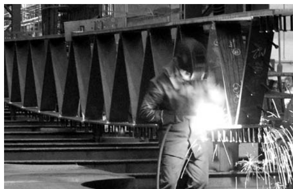
Obr. 19. Svařování ocelové části (most je zde v opačné poloze)
