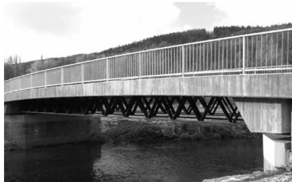
Obr. 20. Pohled na dokončený most
