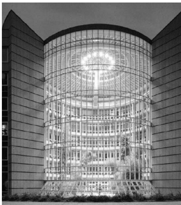
Obr. 1. Vícepodlažní prosklené atrium se skleněnou střešní konstrukcí (Německo)
