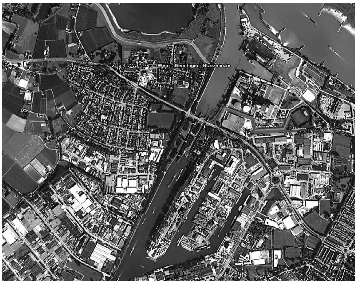
Obr. 1. Letecký pohled na přístavní průmyslovou zónu Nijmegen (Nizozemí)
