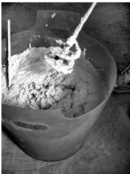
Obr. 4. Příprava sádrové pěny spirálovým míchadlem
