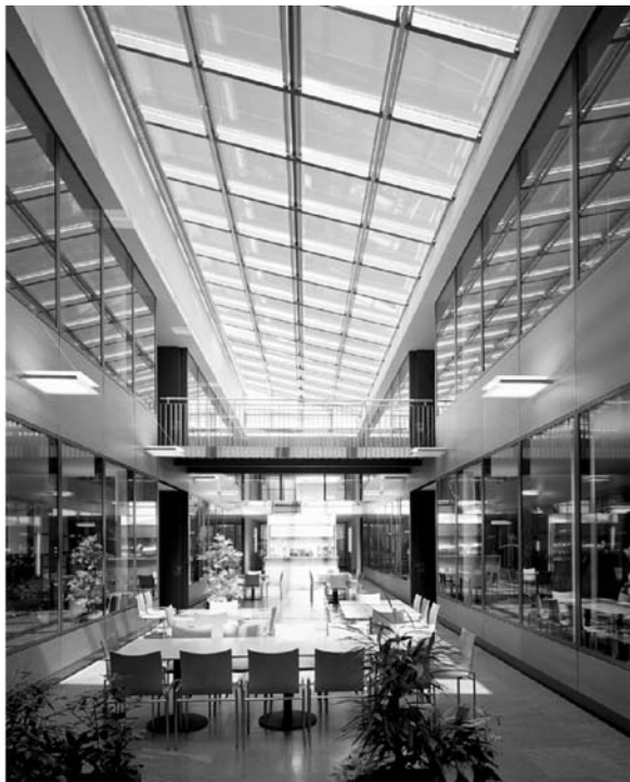
Obr. 2. Prosklená střešní konstrukce
