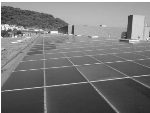
Obr. 4. Prosklená střešní konstrukce (Carrefour Praha)
