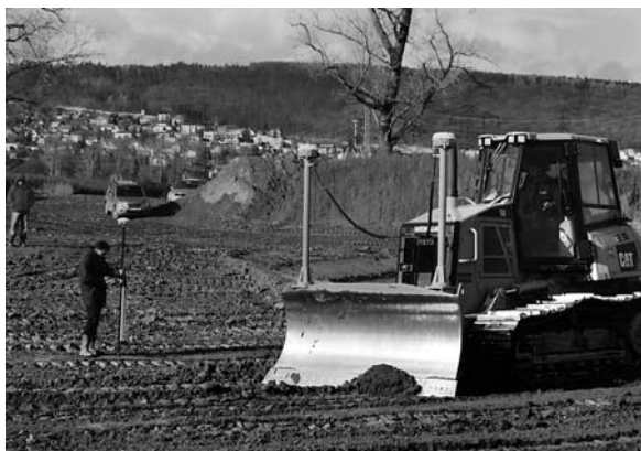
Obr. 1. Dozer CAT D6K s GNSS přijímači Trimble MS990 a roverem Trimble SPS851
