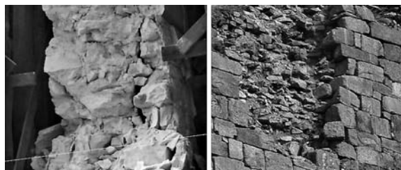
Obr. 2. Příklady kamenného vícevrstvého zdiva
