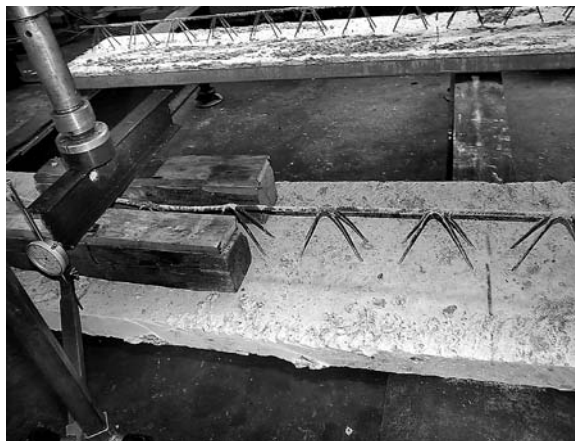
Obr. 14. Počátek vybočení diagonál nad vnitřní podporou
