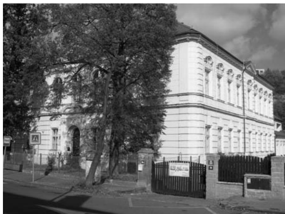
Obr. 1. Jižní a východní fasáda objektu
