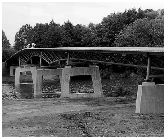
Obr. 4. Lávka pro pěší přes řeku Fulda, Kassel, Německo, 2004 [8]
