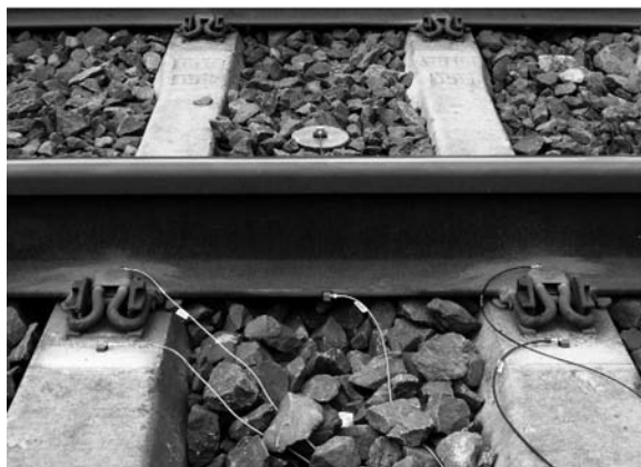
Obr. 1. Osazení kolejového roštu snímači in situ – upevnění Pandrol FC I
