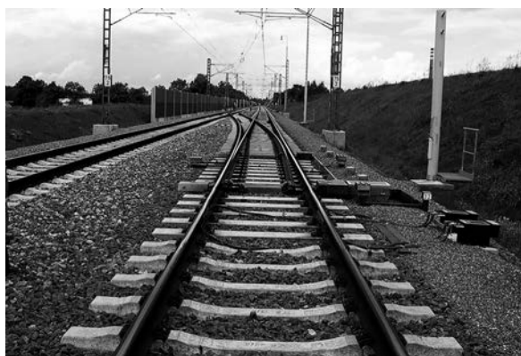
Obr. 2. Výhybka č. 12 s podpražcovými podložkami
