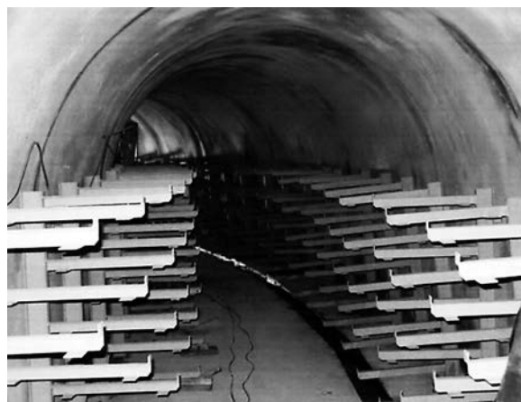
Obr. 1. Ostění z vodonepropustného betonu na kolektoru pod Vltavou [2]
