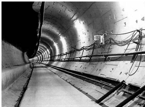
Obr. 5. Prefabrikované segmentové ostění tunelů CTRL s polypropylenovými vlákny [6]
