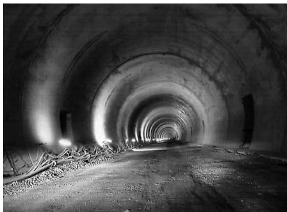
Obr. 2. Nevyztužené sekundární ostění tunelů Nového spojení
