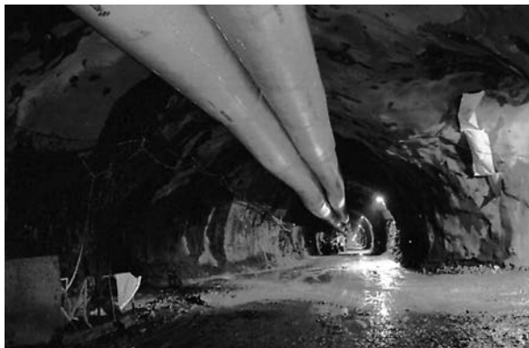
Obr. 3. Jednoplášňové ostění tunelu Siglufjörður na Islandu [5]
