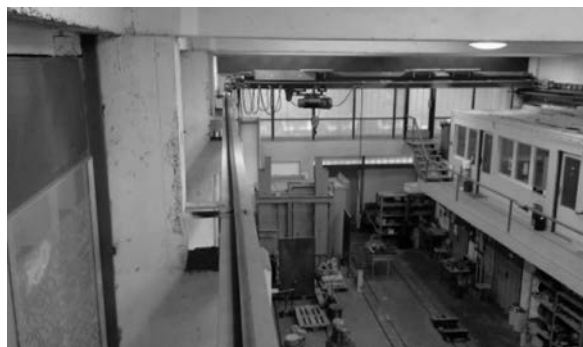
Obr. 1. Jeřábová dráha – pohled shora
