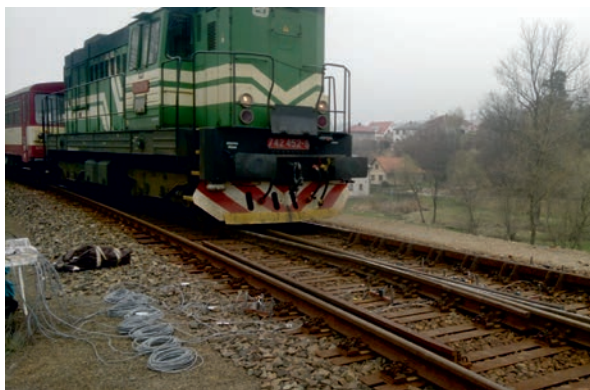
Obr. 2. Pohled na měřenou konstrukci
