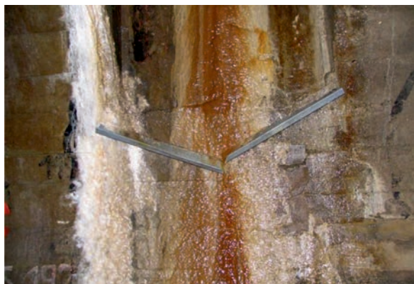
Obr. 5. Záchytné plechy na dilatační spáře
