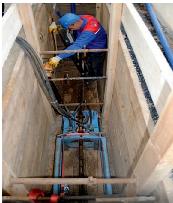
Obr. 5. Destrukce stávající inženýrské sítě, obnova v původní trase
