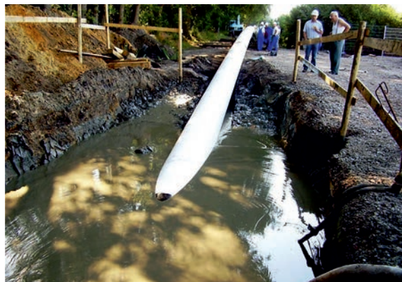
Obr. 3. Bezvýkopová technologie HDD
