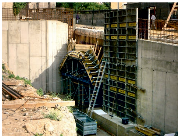
Obr. 7. Bednění mostního oblouku (foto J. Mrzílek, 2011)
