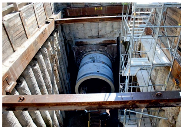
Obr. 4. Bezvýkopová technologie mikrotunelování
