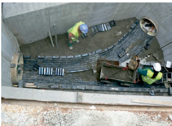
Obr. 8. Stavba spojné komory na stoce (foto J. Mrzílek, 2011)
