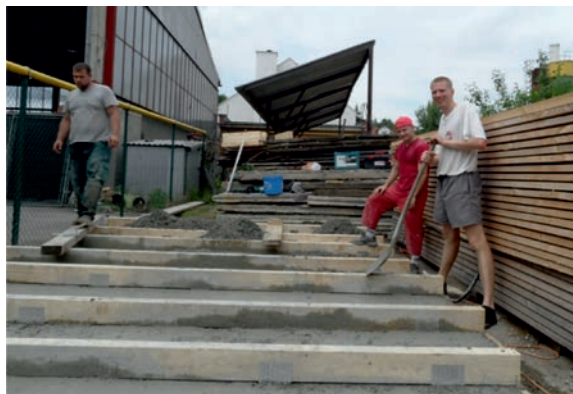
Obr. 3. Betonáž panelů
