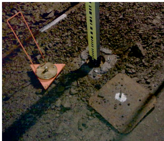
Obr. 4. Nivelační lať na jednom z nových bodů v podzemí, vedle těžká nivelační podložka
