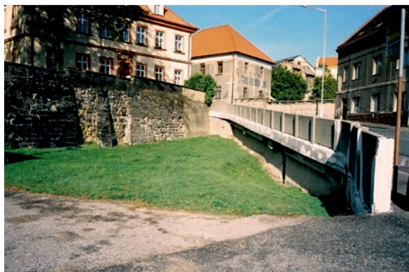
Obr. 2. Původní betonová rampa vjezdu do historického jádra města Slaný (foto J. Novotný, 2006)
