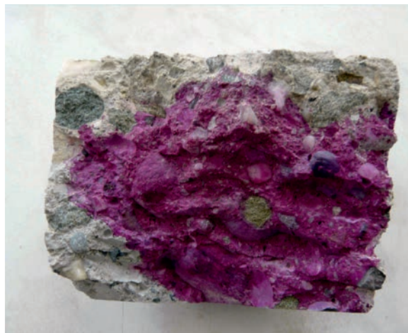
Obr. 4. Aplikace fenolftaleinu na povrch betonu
