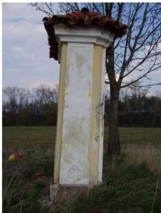
Chybí svislice – nelze dodatečně zjistit jestli je nakloněná kaplička, nebo dotyčný fotogrametr.
