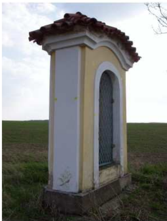
Chybí svislice – nelze dodatečně zjistit jestli je nakloněná kaplička, nebo dotyčný fotogrametr.
