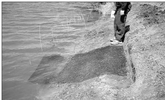
Obr. 3. „Zpracování“ geosítí do svahu tvořícího břeh nádrže (foto M. Šlezingr)
