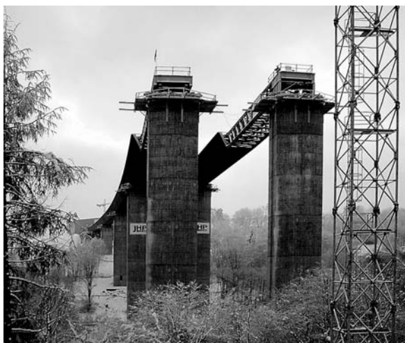
Obr. 9. Pohled na vysouvané konstrukce zespodu
