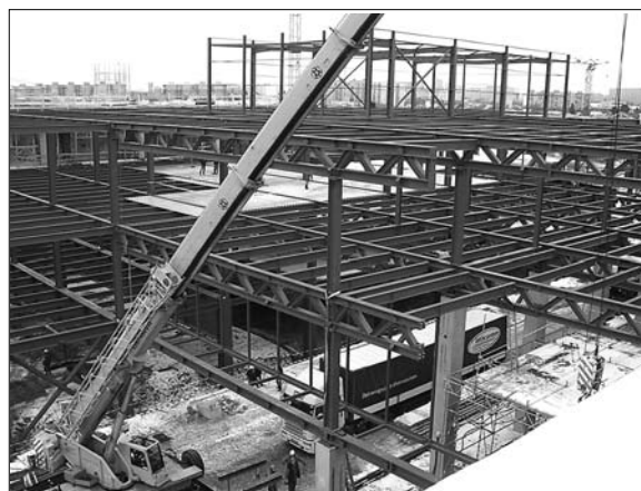
Obr. 3. Přemostění a ocelová konstrukce nad metrem
