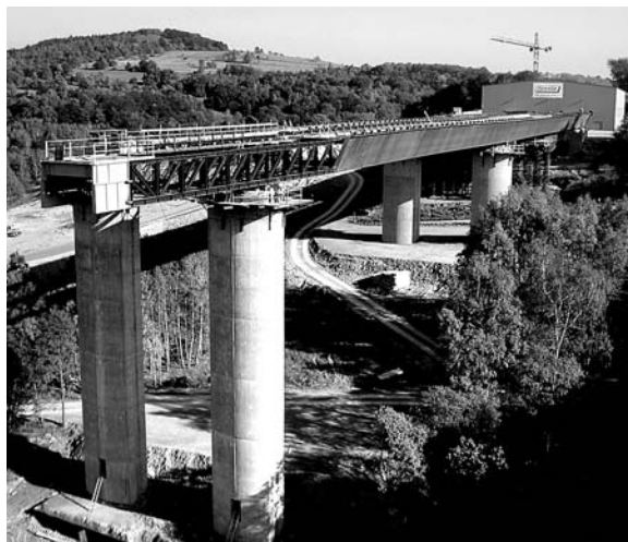
Obr. 7. Pohled na konstrukci při výsunu
