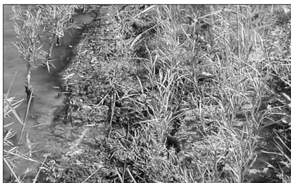
Obr. 7. Výrazný ústup břehové čáry v oblasti stabilizované pouze biologicky (foto M. Šlezinger)
