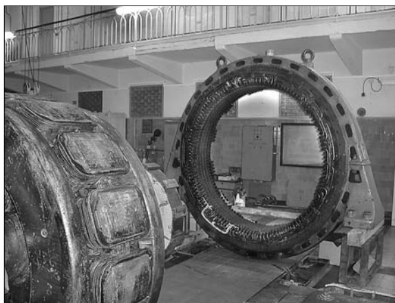
Obr. 3. Oprava původního generátoru
