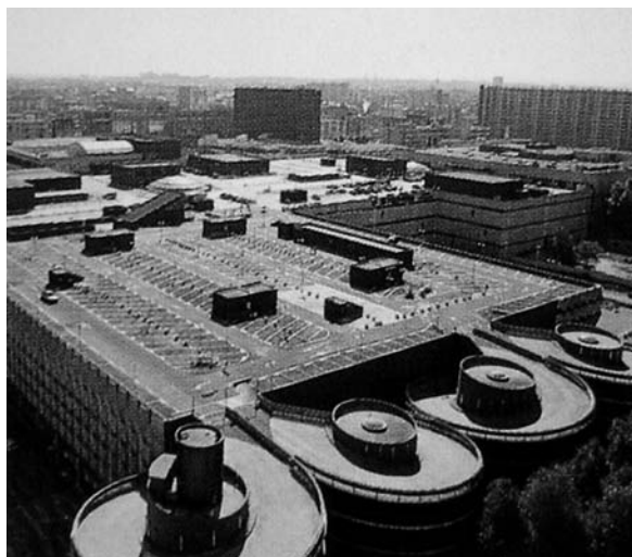
Obr. 1. Příklad pojižděné střechy (La Part Dieu, Lyon)
