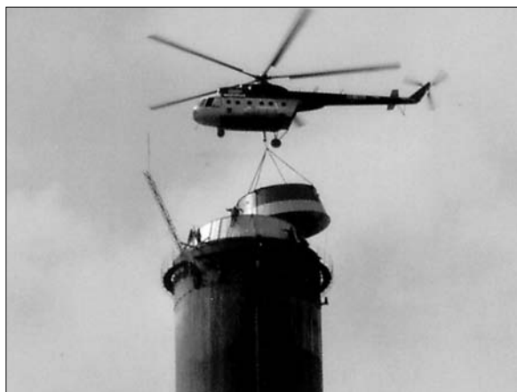
Obr. 6. Osazování středního dílu konfuzoru na komín
