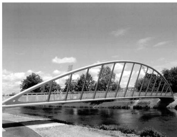
Obr. 15. Ocelová lávka přes Vltavu v Českých Budějovicích
