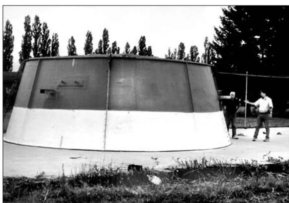
Obr. 8. Střední montážní díl laminátového konfuzoru připravený k osazení
