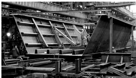
Obr. 3. Výroba ocelové konstrukce
