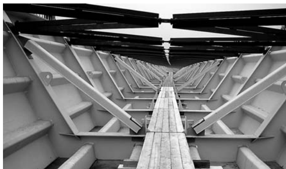
Obr. 4. Pohled do ocelové konstrukce
