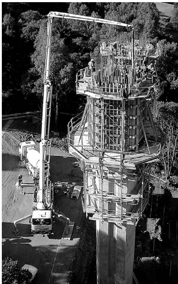
Obr. 2. Výstavba jednoho z pilířů
