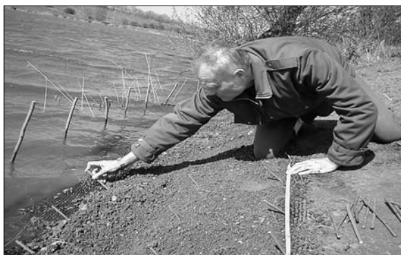
Obr. 6. Osazování vrbových řízků (foto M. Šlezinger)
