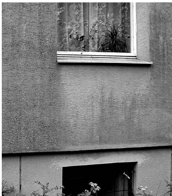
Obr. 2. Vliv oplechování okenního parapetu na výskyt řas
