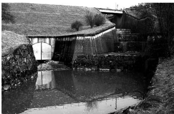
Obr. 1. Kaskádový skluz, portál štoly a vývar na VD Fryšták
