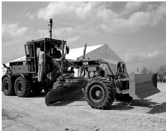
Obr. 3. Nivelační systém mmGPS umístěný na graderu CAT 143H
