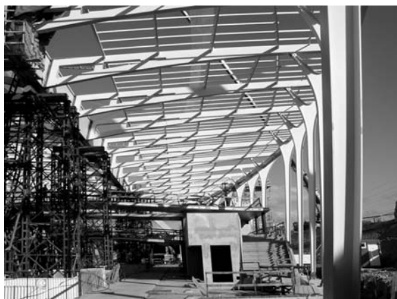
Obr. 3. Montážní podepření průvlaků
