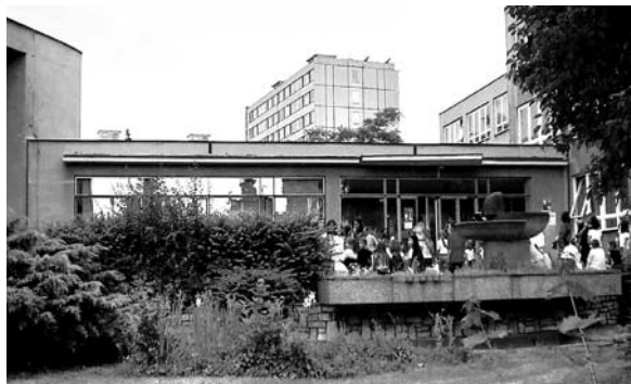
Obr. 1. Objekt ZUŠ v Mostě
