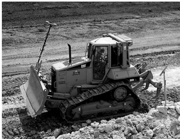
Obr. 6. Dozer CAT D6N s šesticestnou radlicí a duální anténou GPS
