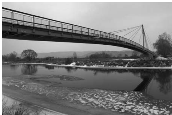
Obr. 1. Celkový pohled na lávku v Radotíně
