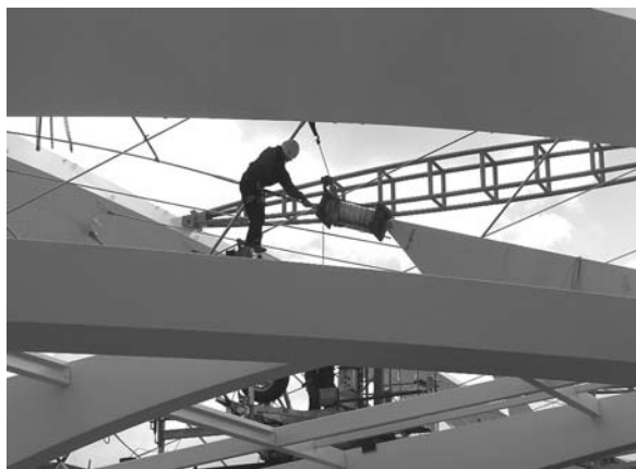
Obr. 6. Montáž dlouhého táhla
