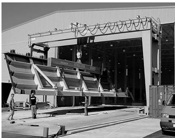
Obr. 6. Konstrukce vysouvána z haly
