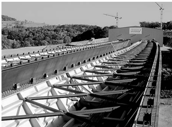
Obr. 5. Manipulace s dílcem u montážní haly
