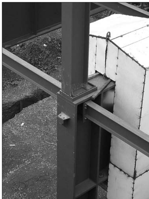
Obr. 5. Uložení sloupu horního skeletu do vaničky
