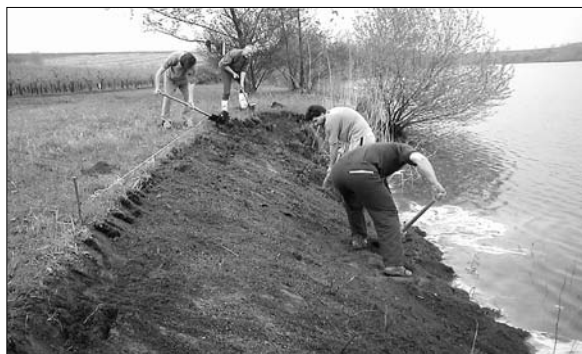
Obr. 2. Úprava břehu pro založení experimentální plochy (foto M. Šlezingr)
