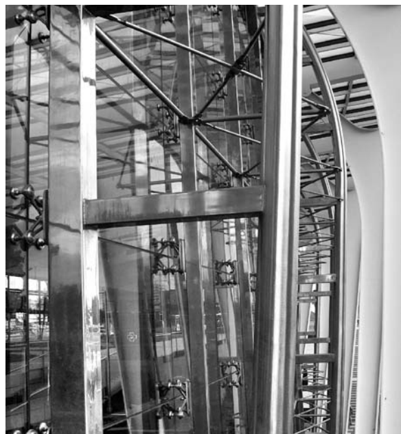
Obr. 1. Konstrukce prosklené fasády stanice metra Střížkov
