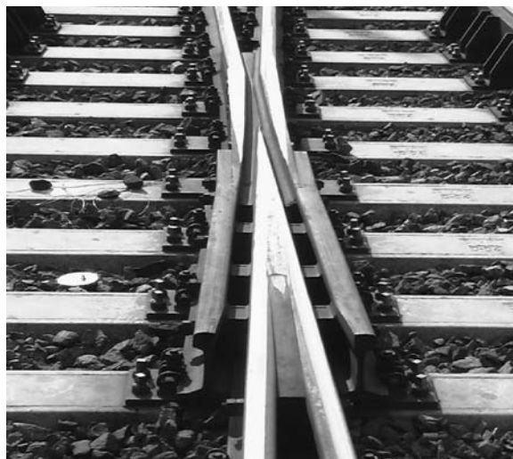
Obr. 2. Měřicí polokoule se snímačem zrychlení, výhybka s pevným hrotem srdcovky
