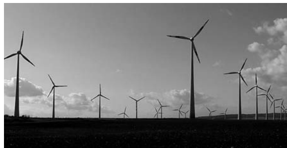
Obr. 1. Část větrného parku z roku 2006, ležící za vesnicí Dardesheim
