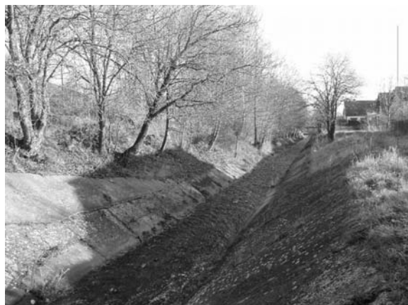
Obr. 1. Betonové koryto Podkrušnohorského přivaděče, rok 2008
