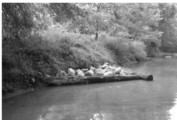
Obr. 1. Představa interakce revitalizačního prvku výhonového typu s okolním proudem a ukázka jeho skutečné realizace na vodním toku
