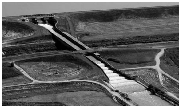
Obr. 1. Odberný objekt Dobrohošť
