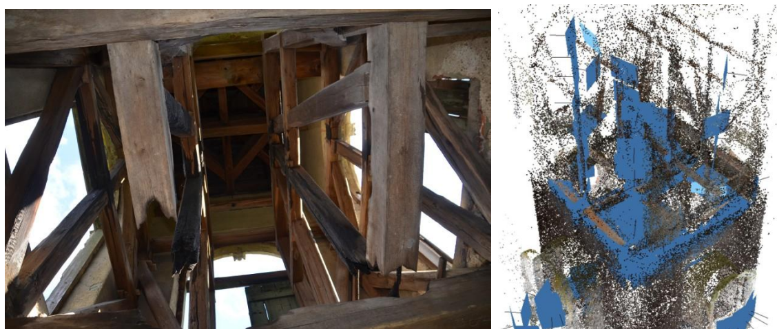
Obr. 5 Širokohlá snímka poškodeného krovu (vľavo) a konfigurácia snímkovania interiéru zvonice pomedzi trámy (vpravo)
