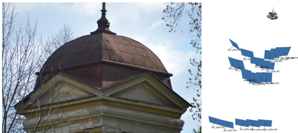
Obr. 4 Strecha zvonice na snímke s 270 mm ohniskovou vzdialenosťou (vľavo) a konfigurácia jej snímkovania (vpravo)
