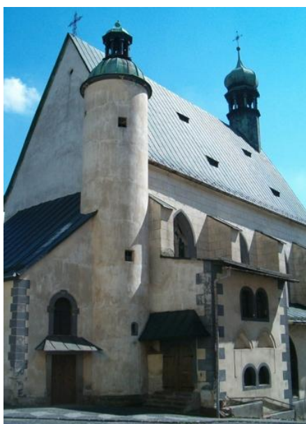
Obr. 2 Kostol sv. Kataríny – severný portál
