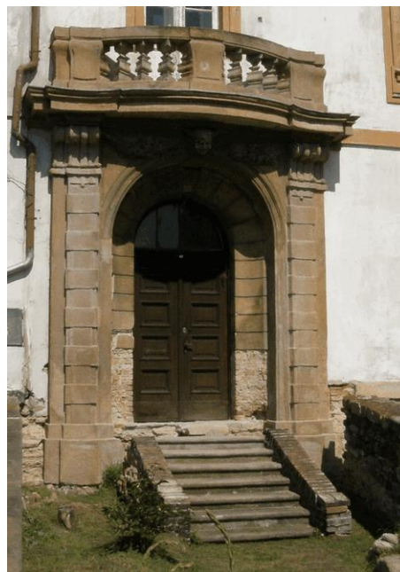
Obr. 1.2: Barokní portál v jihovýchodním průčelí
