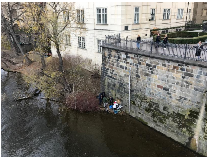
Obr. 2: Poloha vybraného pískovcového kvádru v opěrné zdi Křížovnického náměstí a probíhající měření [převzato z 21].
